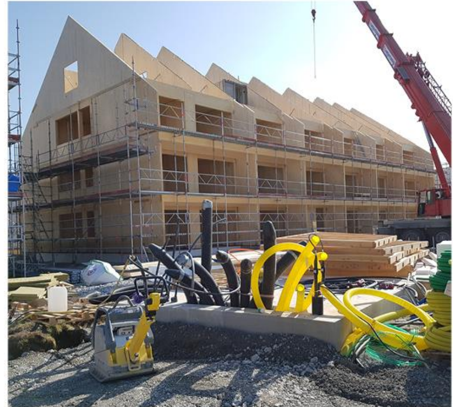
Kv Sergeanten, Massiv KI-trä i stomme, bjälklag , ytter- och innerväggar.
