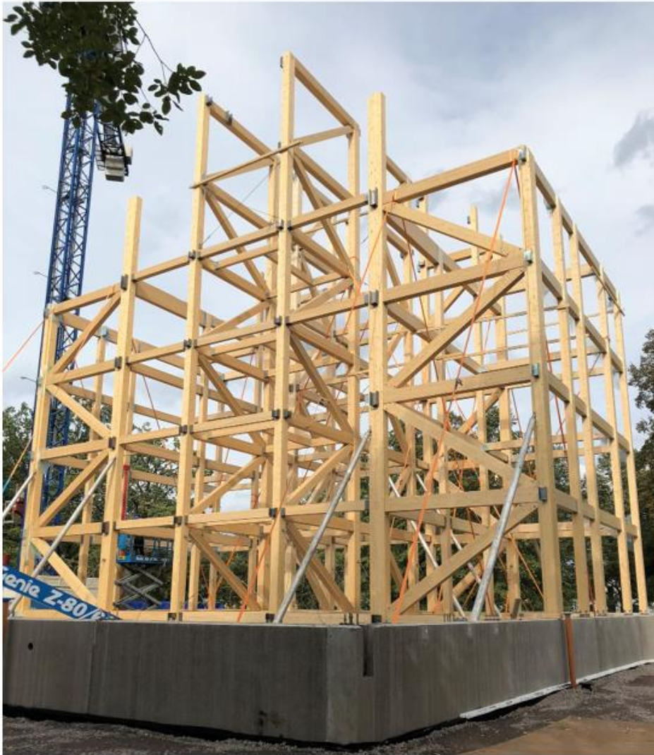
Kv Eken i Mariestad. Pelar/Balk system med "Ripa-bjälklag"/LVL och utfackningsväggar.
