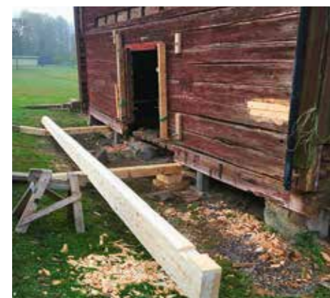
På timmerhus går delar att byta ut, husen kan även plockas ner för att sättas upp någon annanstans. På bilden en timrad magasinbyggnad där sylvilken ska bytas ut.
