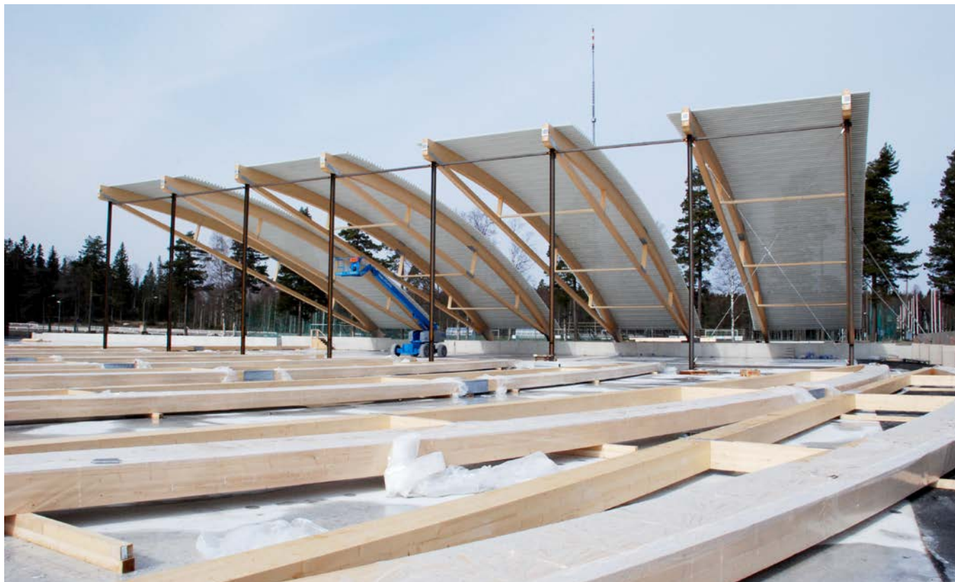
Montage av bandyhall med limträstomme, Nässjö.
