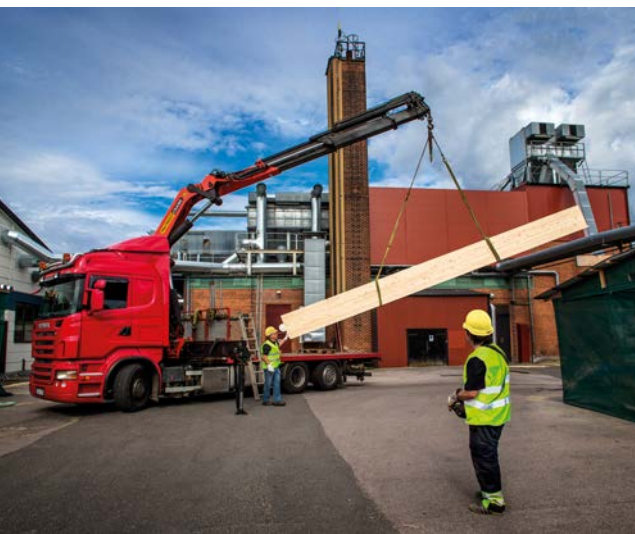
Lossning av limträelement med hjälp av kran från lastbil.
