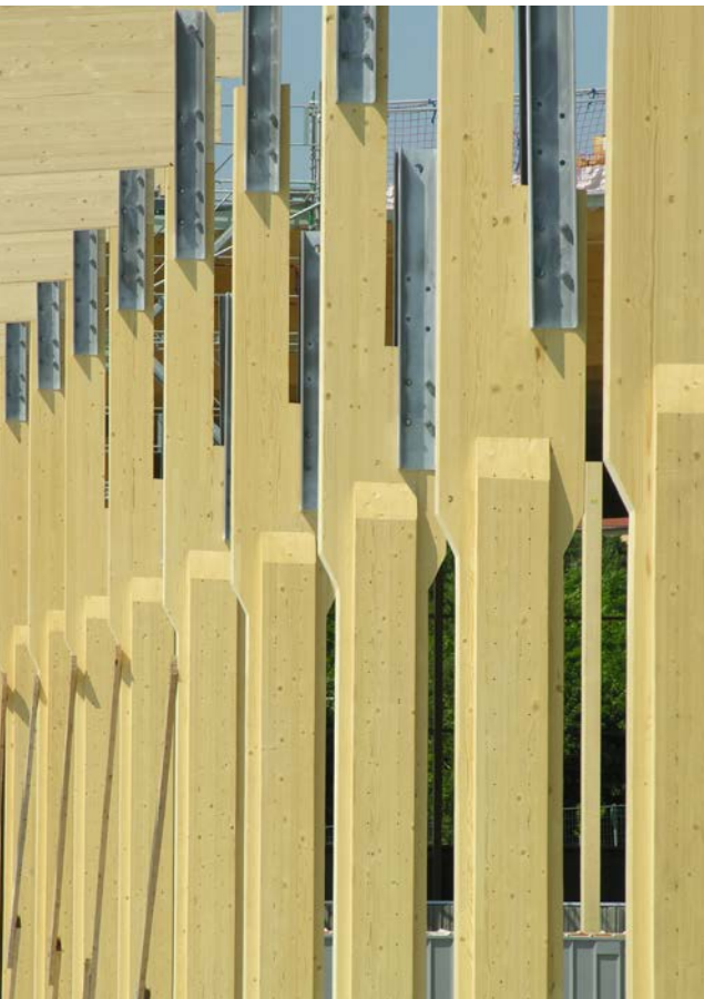
Monterade limträpelare med laskar av UPE-profil i pelartopp.
