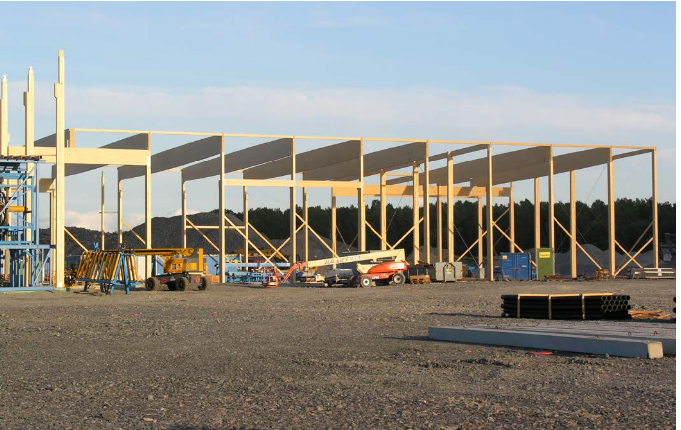
Limträstomme till industribyggnad under uppförande, Norrköping.
