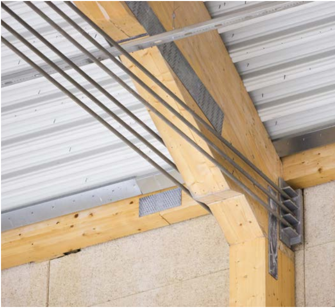
Infästningsdetalj i en bandyhall med limträstomme, Nässjö.
