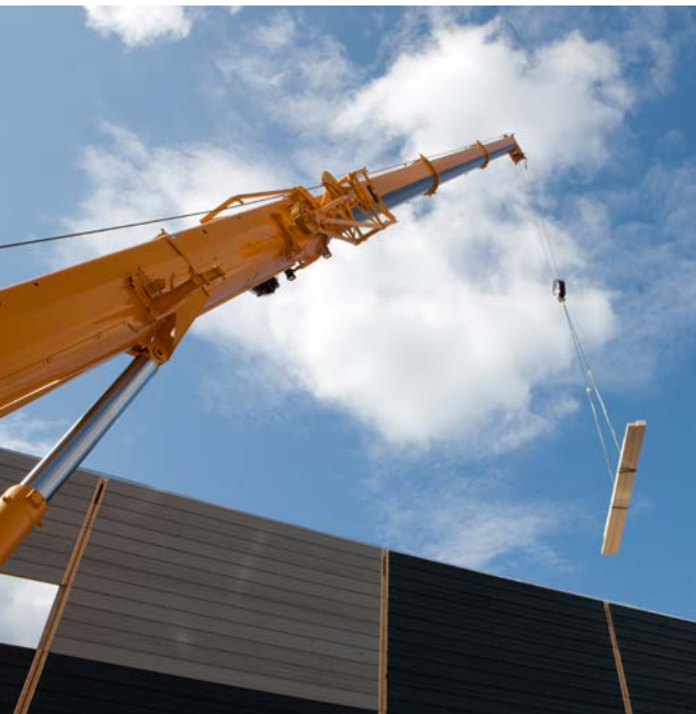
Lyft av limträelement med mobilkran.
