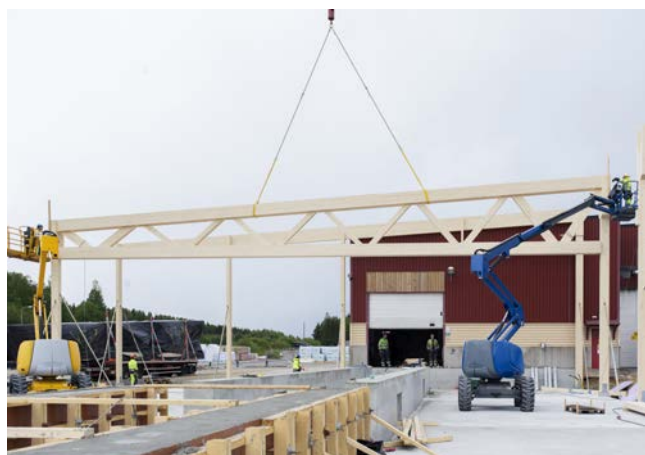
Montage av limträstomme under sommarhalvåret utan väderskydd.
