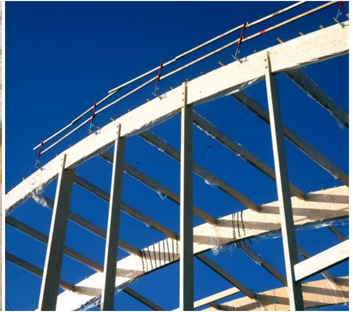
Limträbågar med gavelpelare och åsar av limträ.
