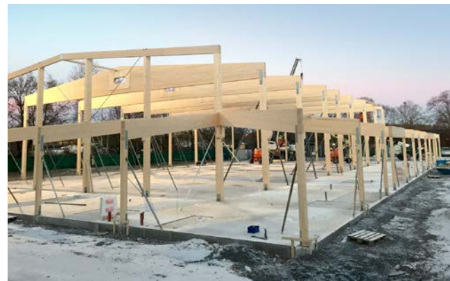
Temporär stagning vid montage av limträstomme.
