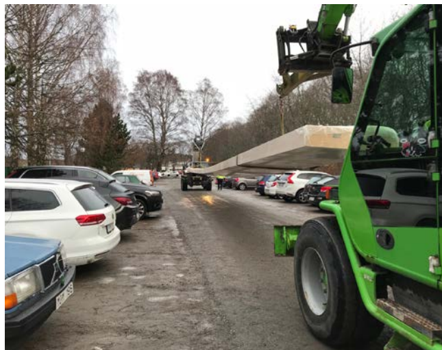
Transport av lång limträbalk med teleskoplastare på byggarbetsplatsen.
