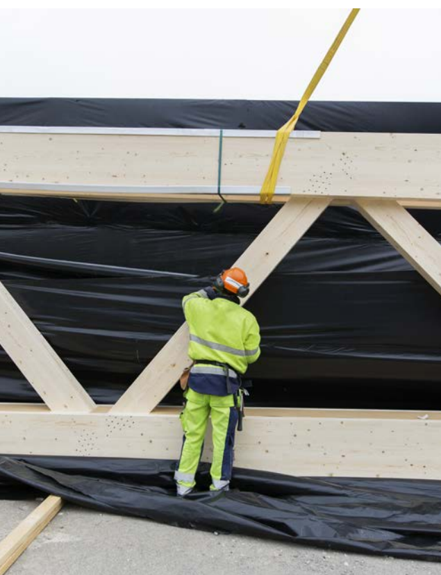
Förberedelse inför lyft av fackverksbalk av limträ.
