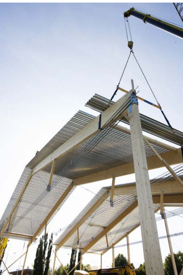
Montage av tredrestakstolar av limträ med dragband på limträpelare.
