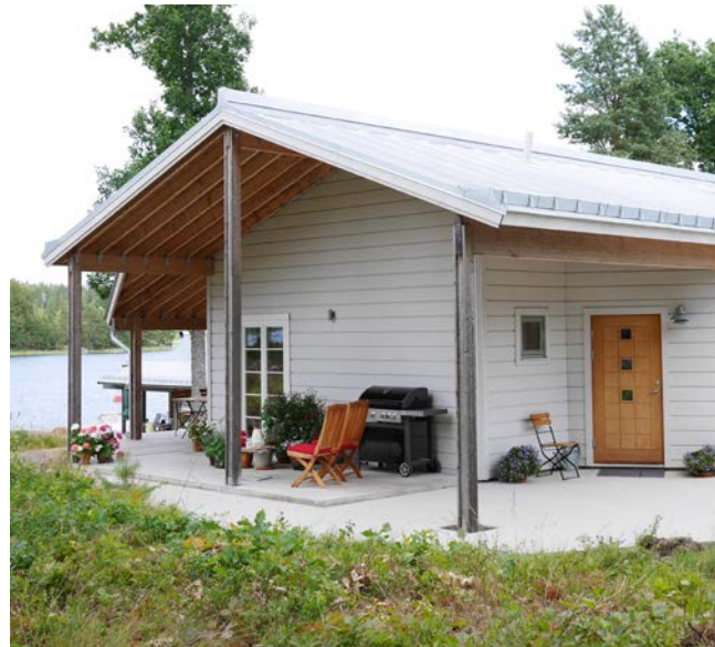
Fritidshus med fasader av limträpanel som täckmålat. Nockbalk och bärlinor av limträ är delvis utomhusexponerade men skyddade under tak.
