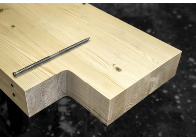
Större urtag kräver ofta förstärkning. Exempel på urtag med rundat horn och skruvförstärkning.
