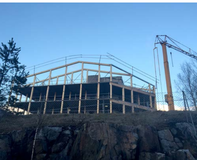
Montage av förrådsstomme med bilburen kran, Haninge. Pelare och takbalkar av limträ samt bjälklag och trapphus av prefabricerad betong.
