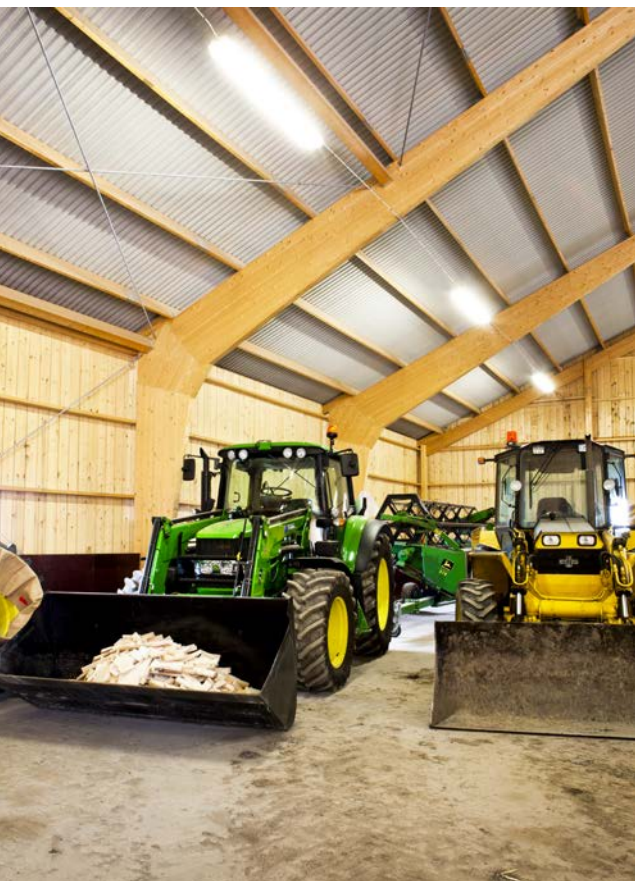
Permanenta vindkryss i färdigställd maskinhall med limträstomme.
