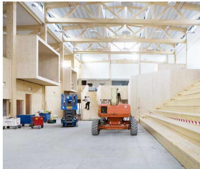
Saxlift och bomlift vid montage av limträ- och KL-trästomme till skolbyggnad, Skellefteå.
