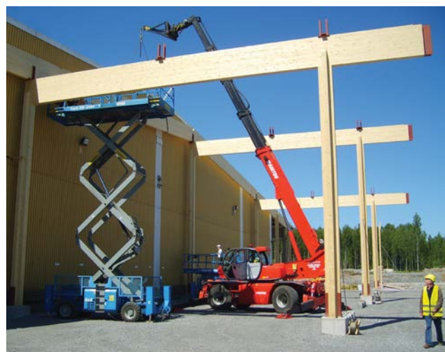
Saxlift och teleskoplastare vid montage av limträstomme.
