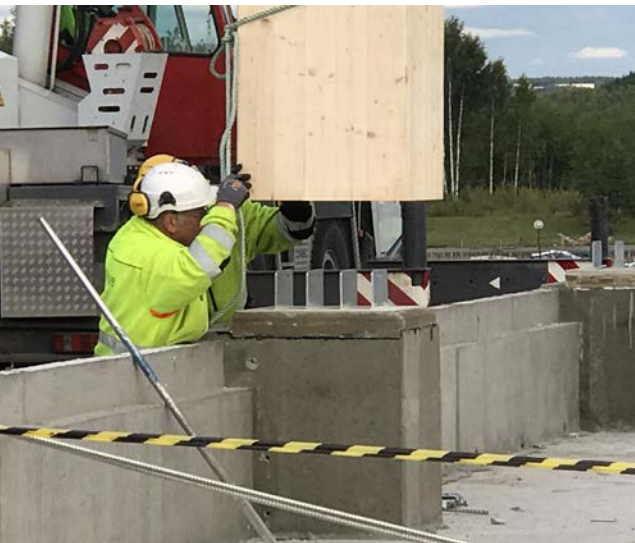
Montage av limträpelare med inslitsade stålplåtar i pelarfot.
