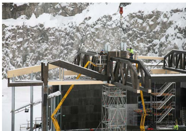
Montage av limträstomme under vinterhalvåret utan väderskydd.
