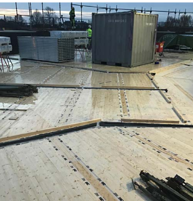
Bjälklag med tejpade skarvar.
