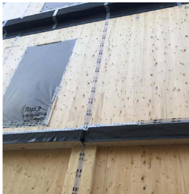
Utvändig vägg med tätade bjälklagskanter och fönster/dörrar.
