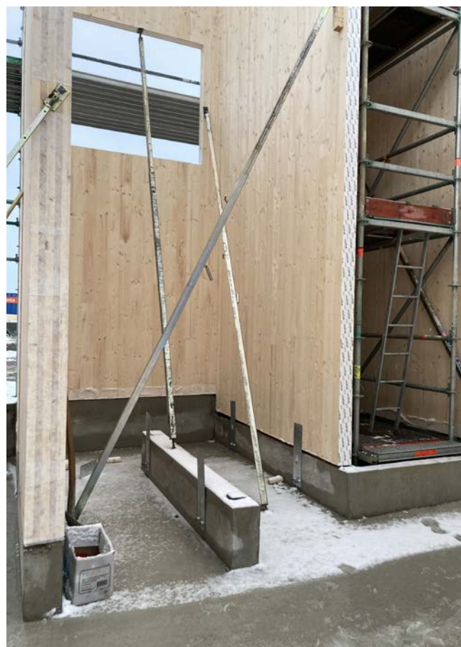
Väggelement placerade på upphöjd sockel av betong med mellanliggande syllisolerings.
