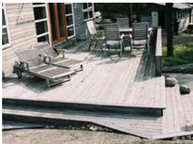
Det är lätt att komplettera altanen med trappor eller ytor att sitta på och avsluta mot berg eller stenbeläggning. Här syns solblekt vitåldrad tryckimpregnerad trall.
