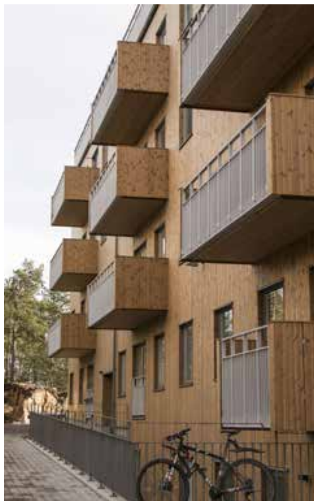
Brandimpregnerad panel. Kv. Taklampan, Hammarbyhöjden, Stockholm.
