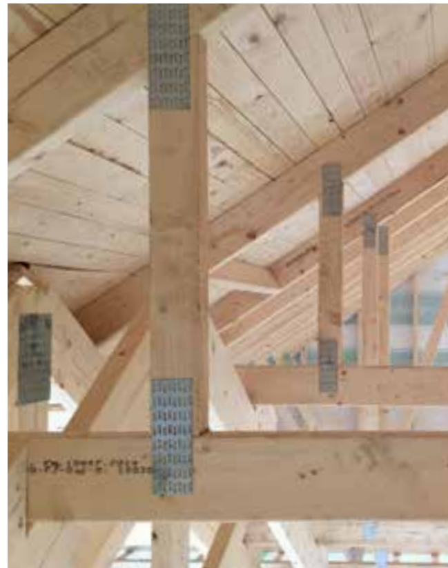
Takstolar av konstruktionsvirke.
