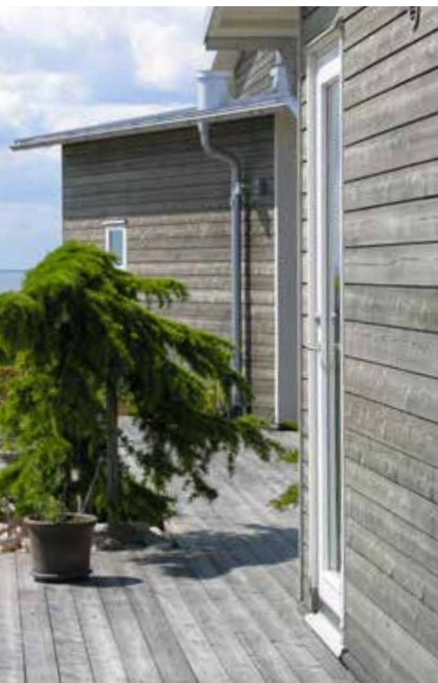
Fasad av gran behandlad med järnvitriol och impregnerad trall av furu.
