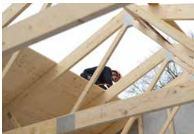
Läggning av underlagsspont.
