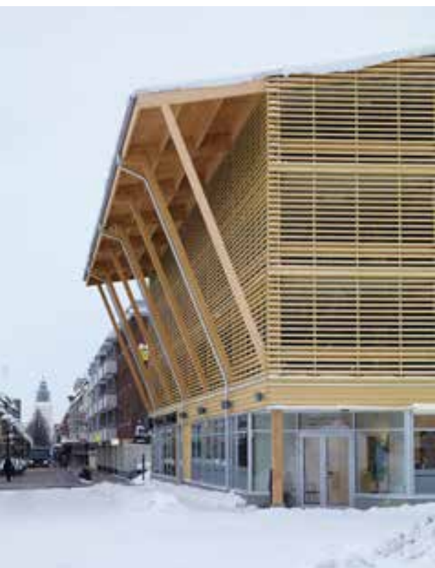
Parkeringshus med bärande bjälklag av KL-trä, Skellefteå.
