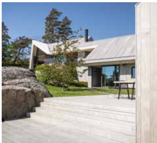
Exempel på acetylerat trä i och på fasad, trappa, tak och trall.
