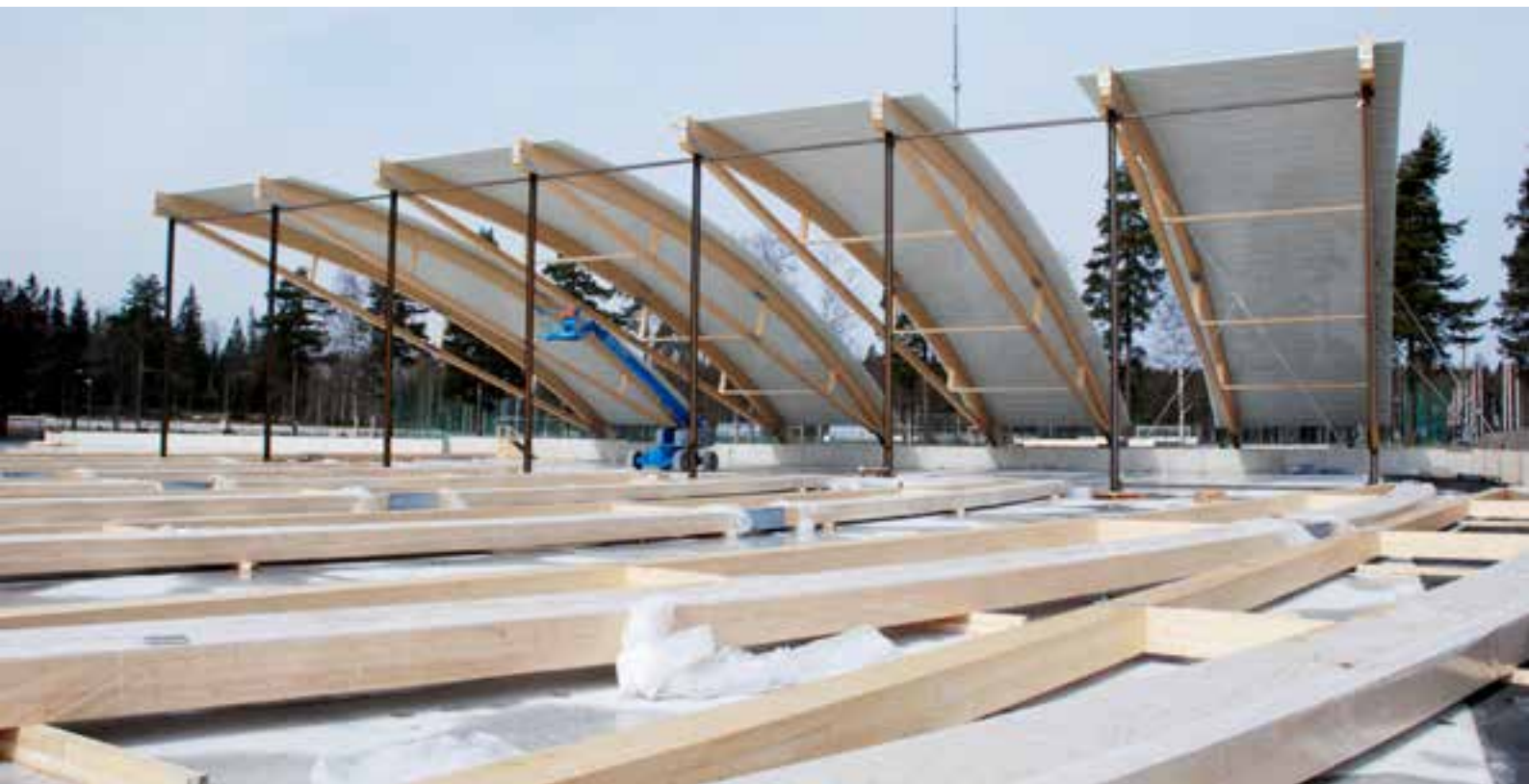
Montage av bandyhall med limträstomme, Nässjö.
