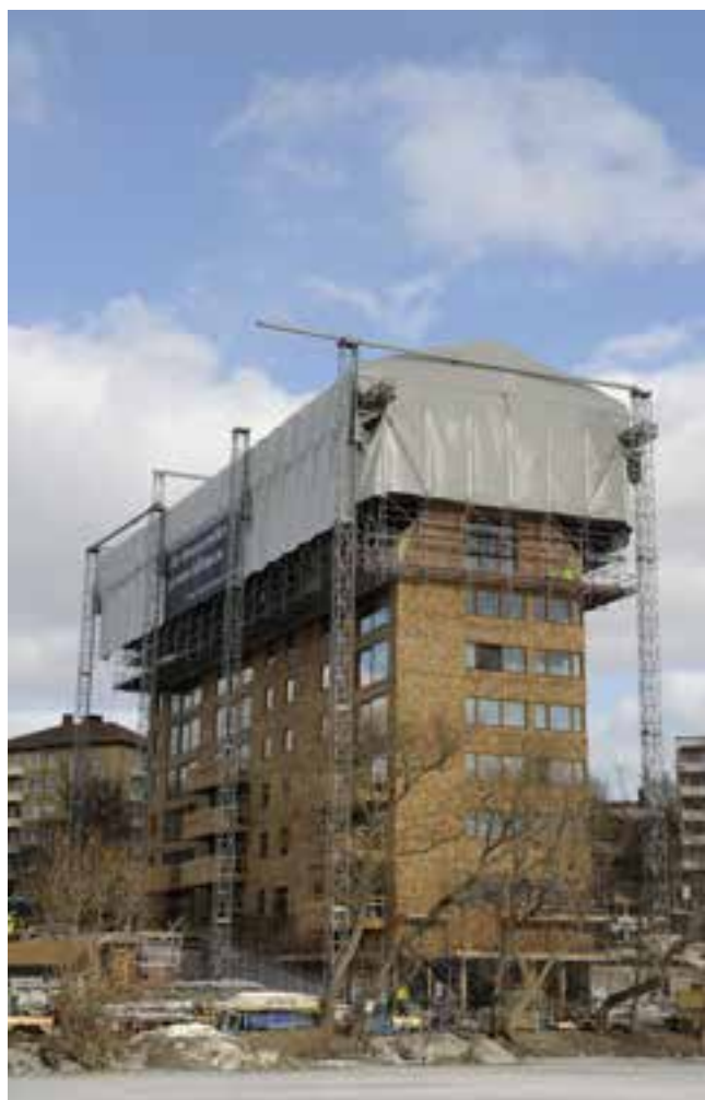
Temporärt klättrande tält som väderskydd vid uppförande av flervåningshus med trästomme, Sundbyberg.
