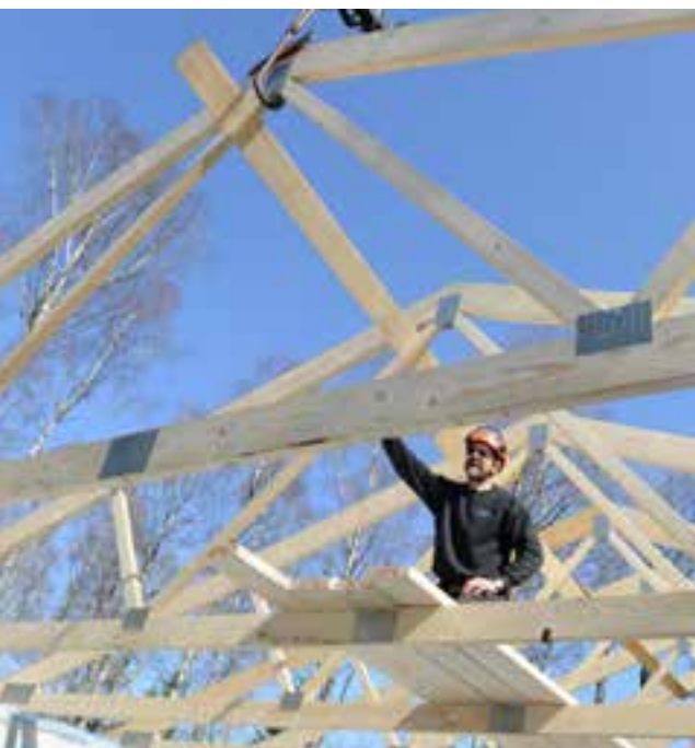
Montage av fackverkstakstolar med temporär stagning.
