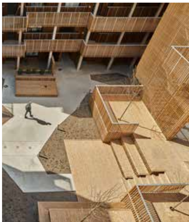
Värmebehandlad och brandskyddsimpregnerad fasad och trall. Flerfamiljshuset Qville, Göteborg.
