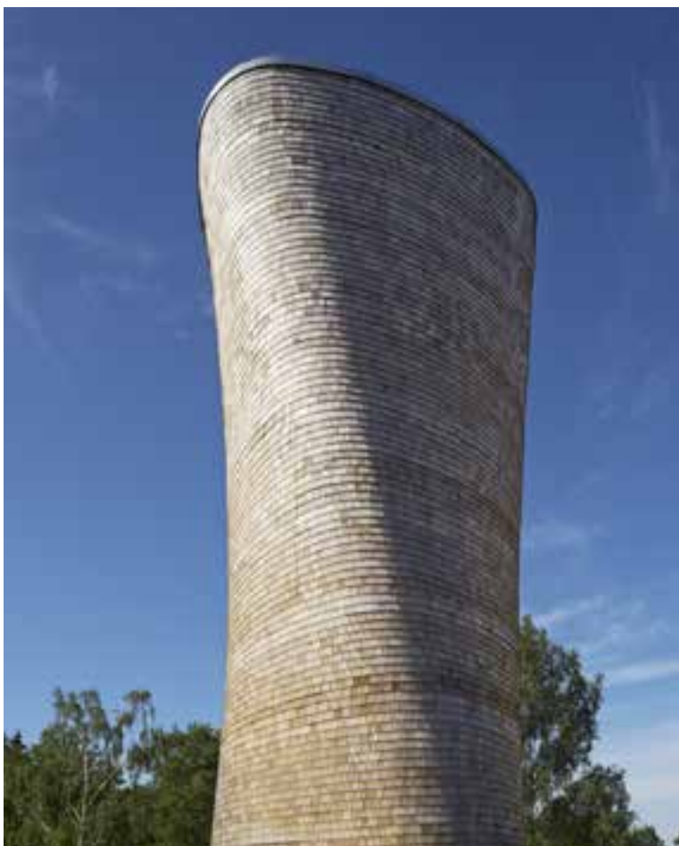
Ventilationstorn för Norra Länken i Stockholm. En originell byggnad med ett originellt byggmaterial. Tornet är uppbyggt av KL-träskivor i gran som är frästa med Computer Numerical Control, CNC, med vertikala dragstag i stål. Fasaden är klädd med träspån av jättetuja (Western Red Cedar).
